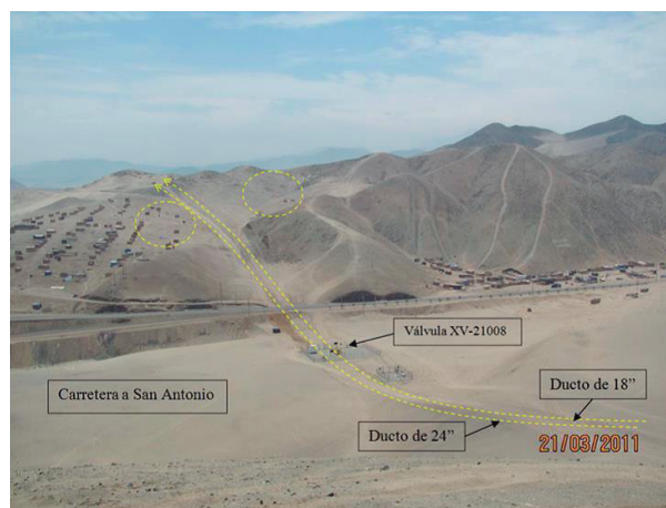
Imagen 2 Viviendas aledañas a los ductos, a marzo 2011 Las líneas indican el trayecto de los ductos de Gas Natural (GN) y Líquidos de Gas Natural (LGN). Fuente: Archivo Osinermin.
